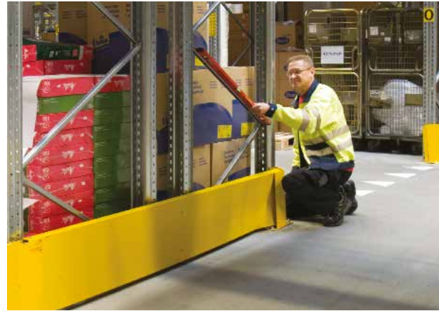
Inspection du rayonnage.
